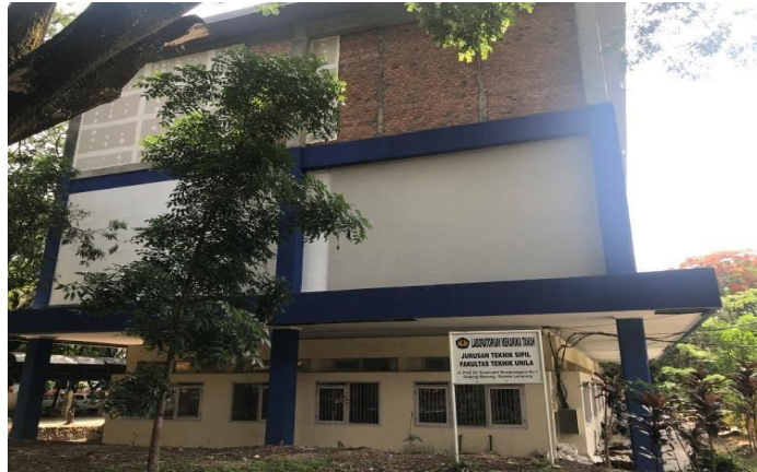
Gambar 19. Bagian depan Gedung C Lab Mekanika Tanah.
