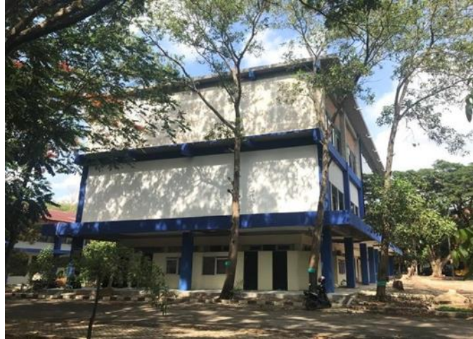
Gambar 21. Bagian belakang Gedung C Lab Mekanika Tanah.
