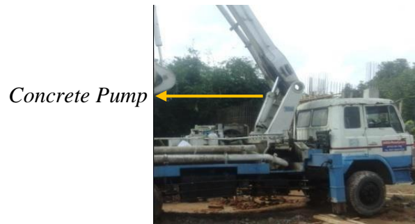
Gambar 3.15 Concrete Pump Sumber : Dokumentasi Lapangan
