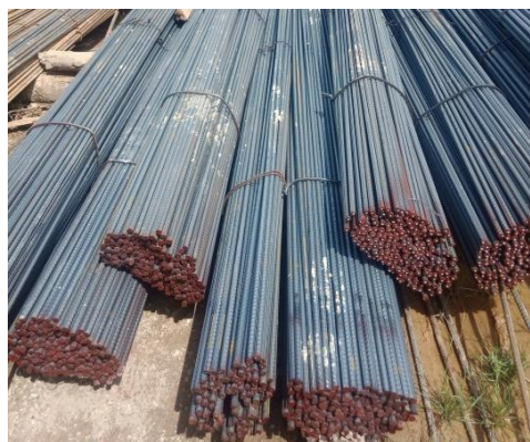
Gambar 3.1 Baja Tulangan Sumber : Dokumentasi Lapangan
