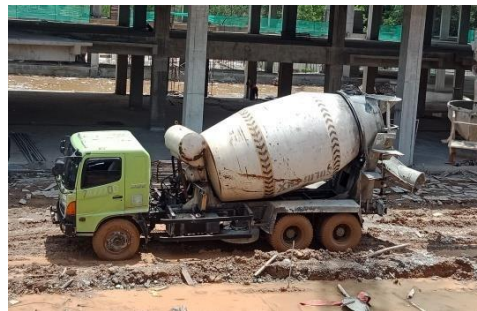
Gambar 3.14 Truck Pencampur Beton ( Mixer Truck ) Sumber : Dokumentasi Lapangan
