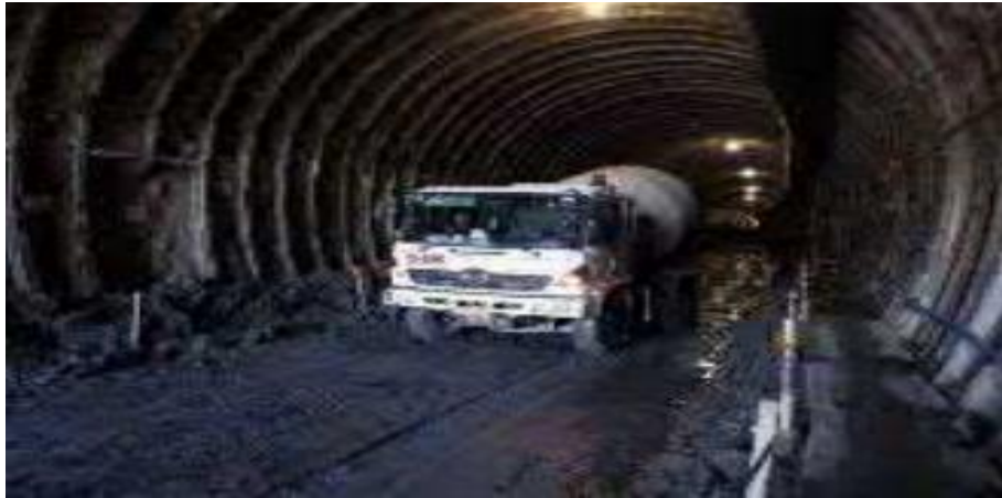
Gambar 5 Penyangga Steel Rib (Sumber: Prasetyo, 2017)
