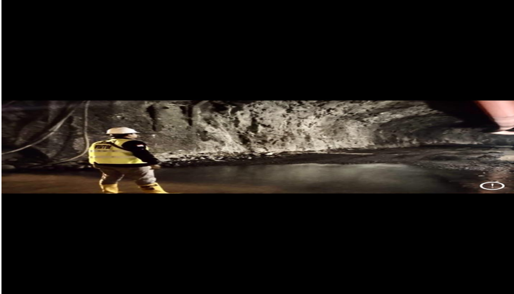
Gambar 3 Pekerjaan Excavation (Sumber: Dokumentasi Pribadi)
