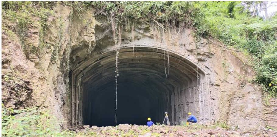
Gambar 1 Terowongan PLTA Batang Merangin. (Sumber: Dokumentasi Pribadi)
