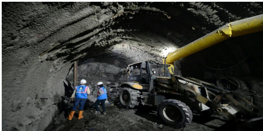
Gambar 4 Pekerjaan Mucking (Sumber: Dokumentasi Pribadi)
