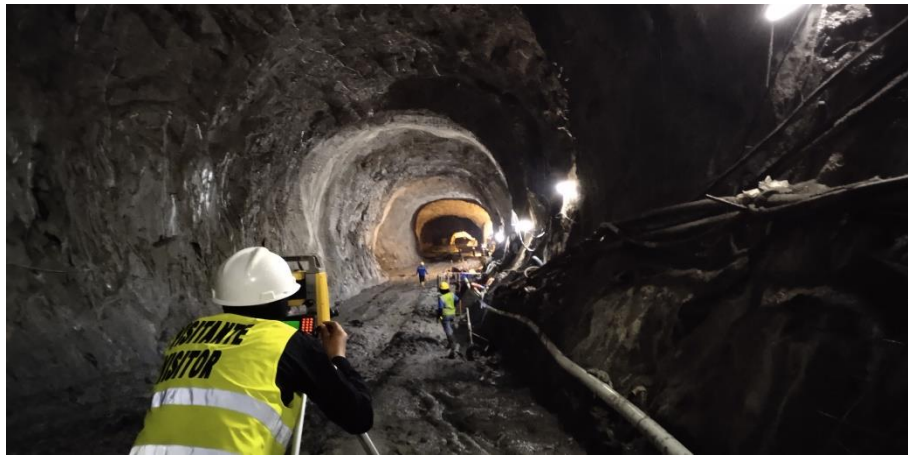
Gambar 2 Pekerjaan Marking (Sumber: Dokumentasi Pribadi)
