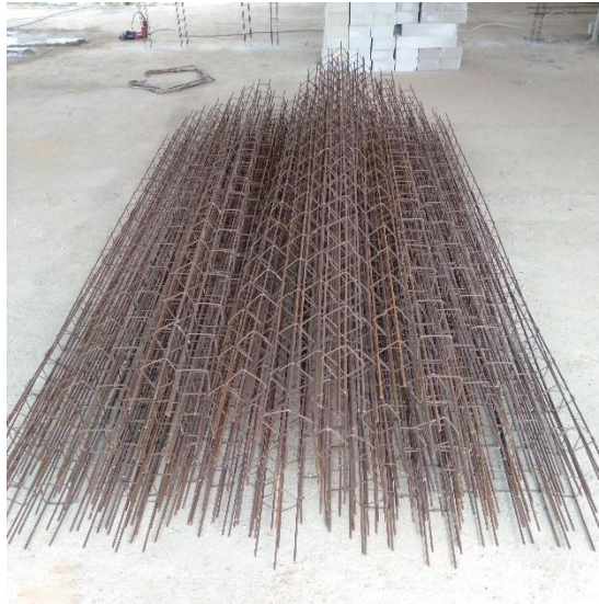
Gambar 3.17 Besi Tulangan 8mm
