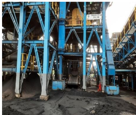
Gambar 1.1. Tampak bagian samping bangunan.
