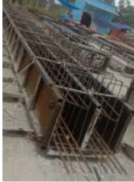
Gambar 3. 42 Bekesting Balok Sumber : Dokumentasi lapangan.
