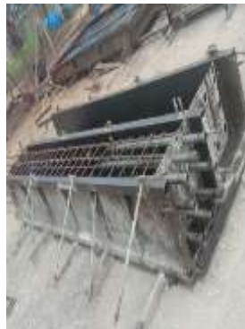
Gambar 3. 41 Bekesting Kolom
