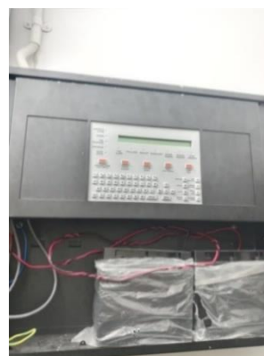
Gambar 3.39. MCP - FA (Sumber : Dokumentasi Lapangan,2021)
