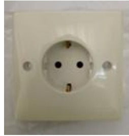
Gambar 3.37. Kotak-Kontak Tunggal (Sumber : Dokumentasi Lapangan,2021)
