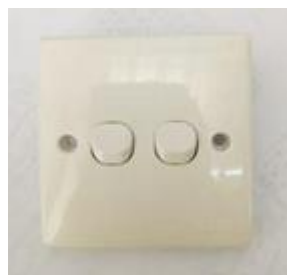
Gambar 3.36. Saklar Ganda (Sumber : Dokumentasi Lapangan,2021)
