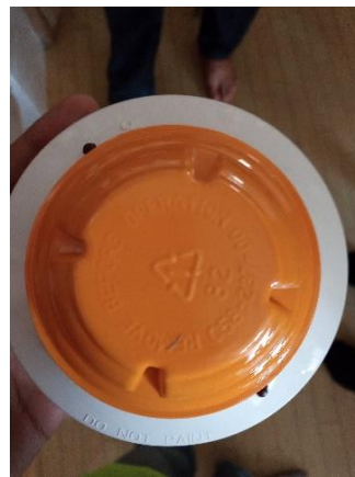
Gambar 3.45. Smoke Detector (Sumber : Dokumentasi Lapangan,2021)
