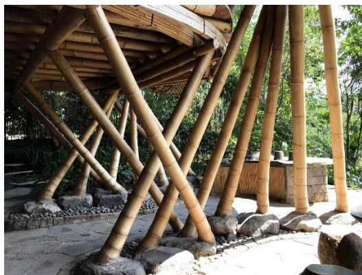
Gambar 4.31 Sambungan Bambu dan Beton Sumber: google.com
