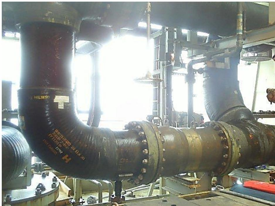
Gambar 2.1. Penerapan Fiber Reinforced Plastic (FRP) pada Fasilitas *offshore* di Teluk Guinea (Amos, 2020)
