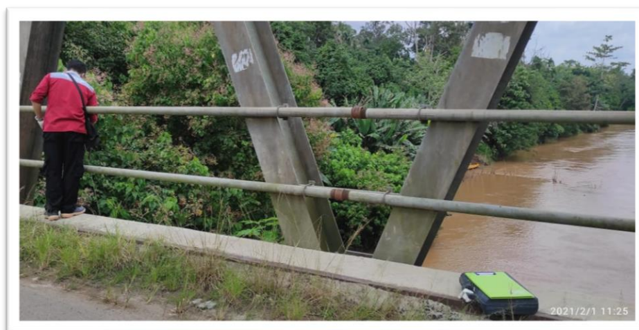
Gambar 6. Bagian Hilir Sungai Way Umpu
