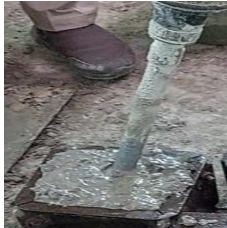
Gambar 3.17. Memadatkan beton segar dengan menggunakan vibrator .
