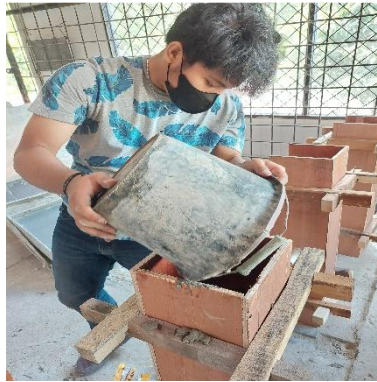
Gambar 3.14. Menuangkan beton segar ke dalam bekisting tiang.
