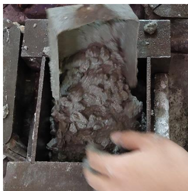
Gambar 3.15. Menuangkan beton segar ke dalam bekisting kubus.
