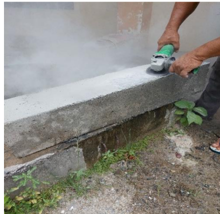
Gambar 3.22. Meratakan dan menghaluskan permukaan tiang beton.
