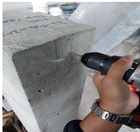
Gambar 3.23. Bor tiang beton untuk pemasangan accelerometer .
