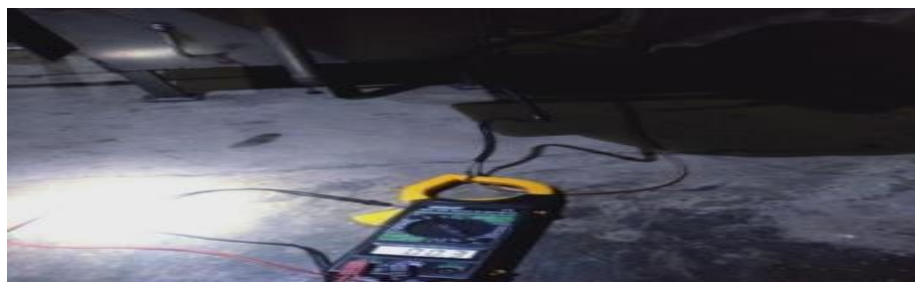
Gambar 24. Pengukuran kuat arus listrik dengan tang ampere .
