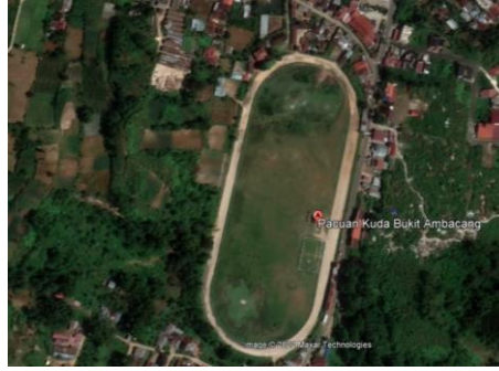
Gambar 2. 8 bentuk Lintasan Gelanggang Bukik Ambacang (Sumber : Google Earth View)
