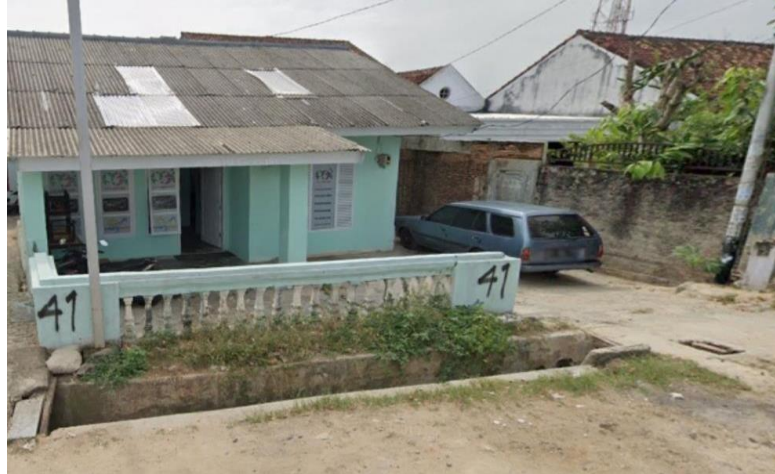
Gambar 3.1 Gedung CV Lampung Selaras Dinamis (Sumber :Dokumentasi Pribadi)
