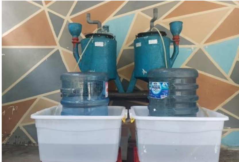
Gambar 12. Instalasi Produksi Biogas yang Digunakan.
