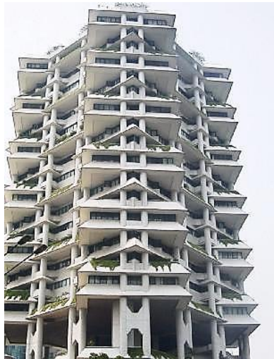
Gambar 2.21 Gedung Wisma Dharmala Sakti
