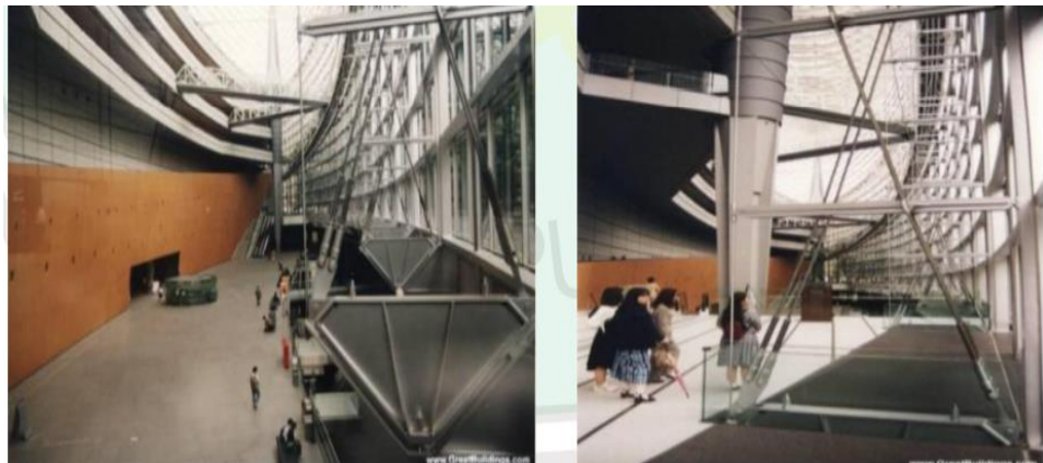
Gambar 2.24 Struktur rangka baja dan Kabel Baja
