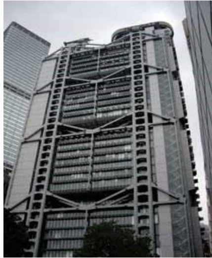
Gambar 2.7 Pemakaian kolom baja sebagai struktur utama bangunan Shanghai and Hongkong Bank Sumber: www.panamario.com/hongkongbank
