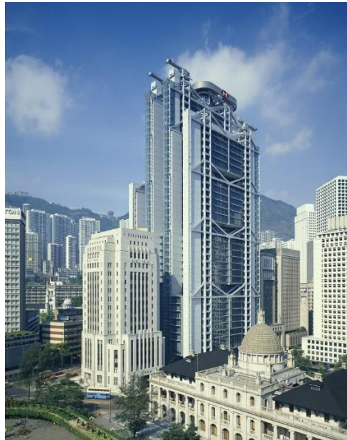
Gambar 2.13 Gedung Hongkong dan Shanghai Bank Sumber: www.dezeen.com/
