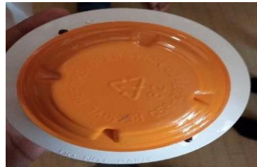
Gambar 3.46. Smoke Detector (Sumber : Dokumentasi Lapangan, 2021)
