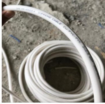
Gambar 3.22. Kabel NYM (Sumber : Dokumentasi Lapangan,2021)
