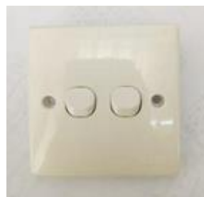
Gambar 3.37. Saklar Ganda (Sumber : Dokumentasi Lapangan,2021)
