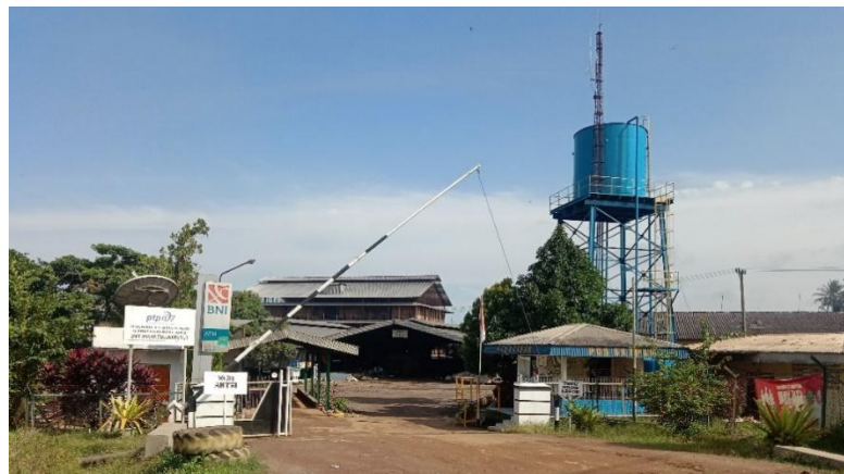
Gambar 3. 1 Lokasi Pabrik PTPN 7 Unit Tulung Buyut
