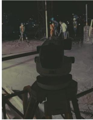
**Gambar 4.10** Mengukur Ketebalan dan Elevasi Plat Lantai dengan *Waterpass*
