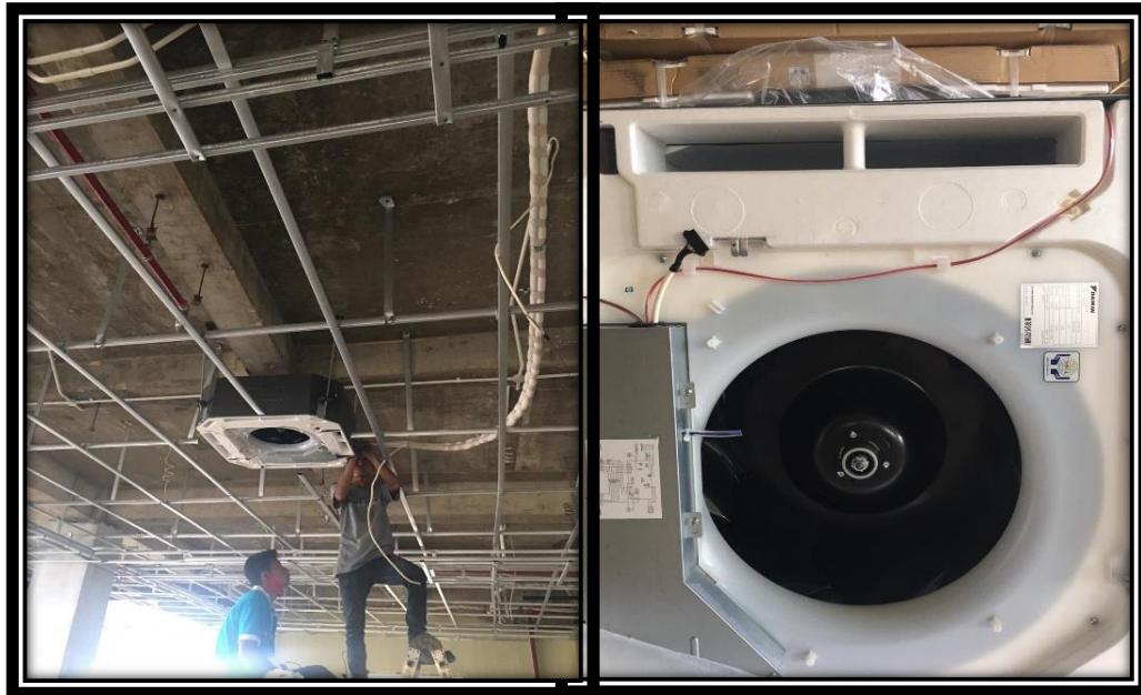
Gambar 4.29 Proses Pemasangan Ac Cassete
