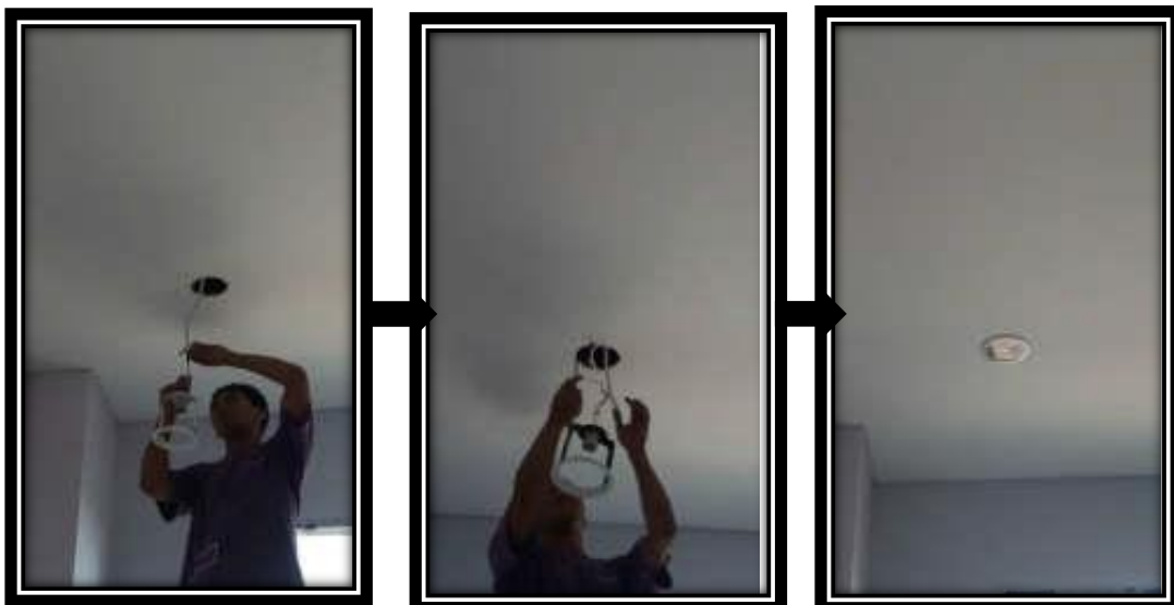
Gambar 4.25 Pemasangan Armature Lampu
