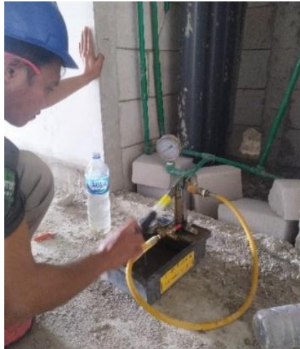
Gambar 3. 48 Tes Tekan Air Bersih Sumber: Dokumentasi lapangan
