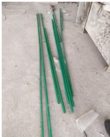
Gambar 3. 12 pipa ppr Polypropylene Random Sumber: Dokumentasi Lapangan
