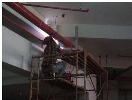
Gambar 3. 45 Pengelasan Pipa
