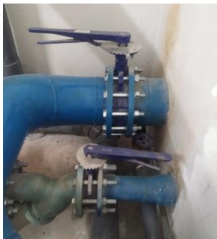
Gambar 3. 22 Butterfly valve Sumber: Dokumentasi lapangan
