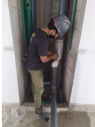
Gambar 3. 53 Pemotongan pipa Sumber: Dokumentasi lapangan
