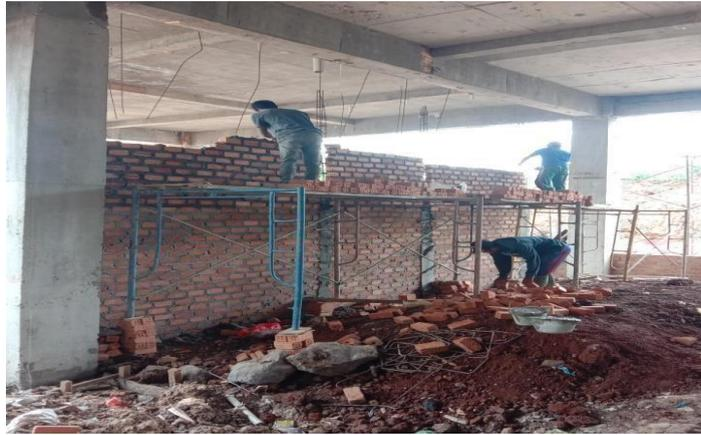
**Gambar 4.10** Pemasangan Dinding Bata Merah
