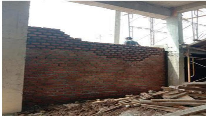
**Gambar 4.11** Pemasangan Dinding Bata Merah
