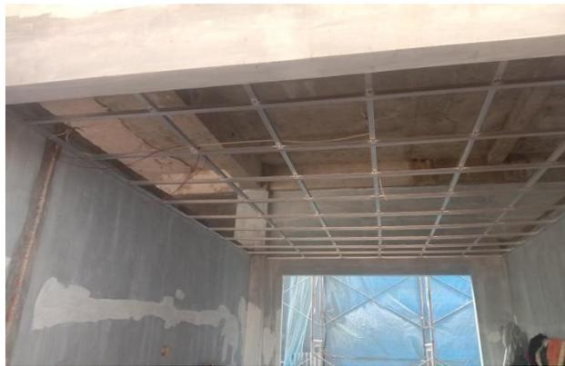
**Gambar 4.43** Pengerjaan Rangka Plafond
