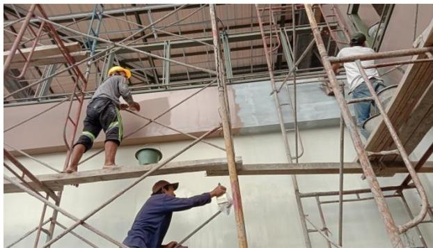
**Gambar 4.28** Proses pengecatan finish pada dinding
