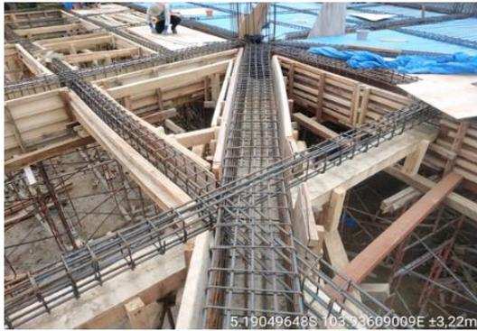
**Gambar 4.21.** Pemasangan Bekisting
