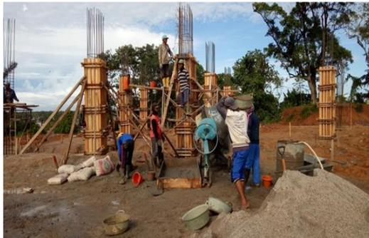
**Gambar 4.10.** Pengecoran Kolom
