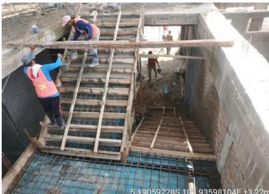
**Gambar 4.28.** Pengecoran Tangga
