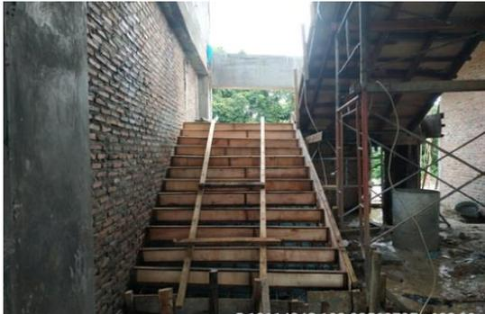
**Gambar 4.26.** Pemasangan Bekisting
