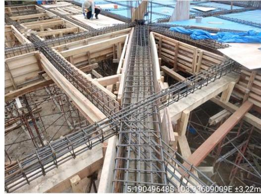
**Gambar 4.14.** Pemasangan Bekisting
