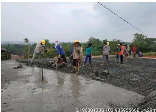
**Gambar 4.23.** Pengecoran Pelat Lantai
