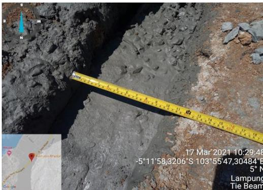
**Gambar 4.19.** Pengecoran Tie Beam
