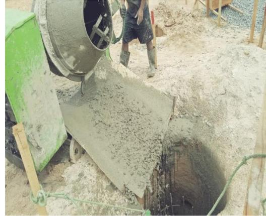
**Gambar 4.4.** Pengecoran Pondasi
