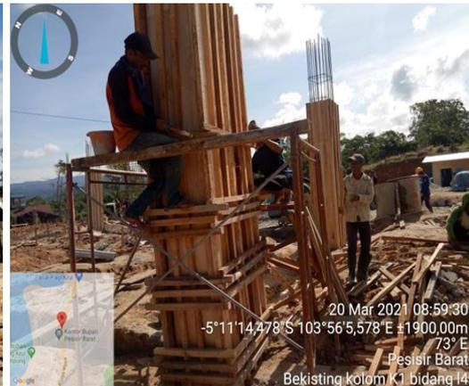
**Gambar 4.9.** Pemasangan Bekisting
