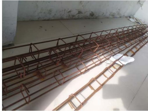
Gambar 3. 17 Besi Tulangan (Sumber : Dokumentasi Penulis,2022)
