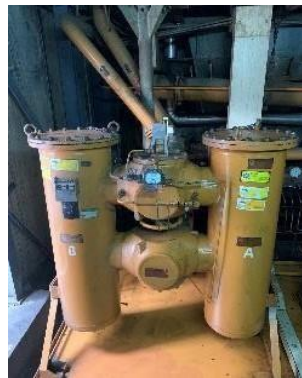
Gambar 2. 11 Twin Filter pada Lube Oil System
