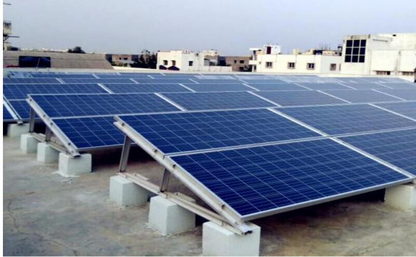
Gambar 2. 6 Metode pemasangan ballast
