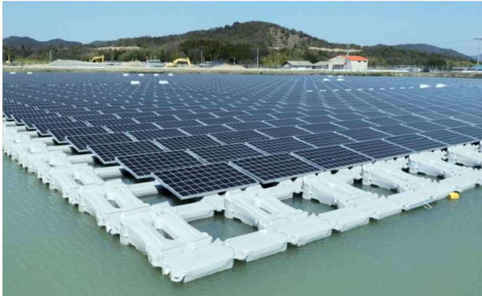
Gambar 2. 9 Metode pemasangan floating
