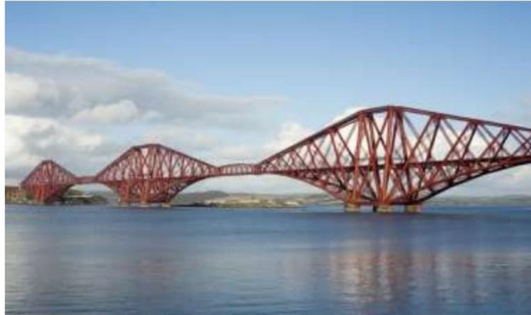
Gambar 11. Jembatan cantilever
