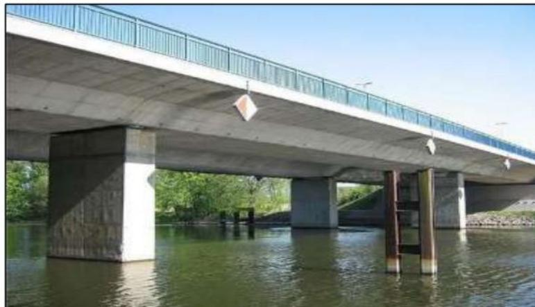
Gambar 3. Jembatan balok beton prategang
