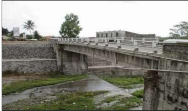
Gambar 2. Jembatan balok beton
