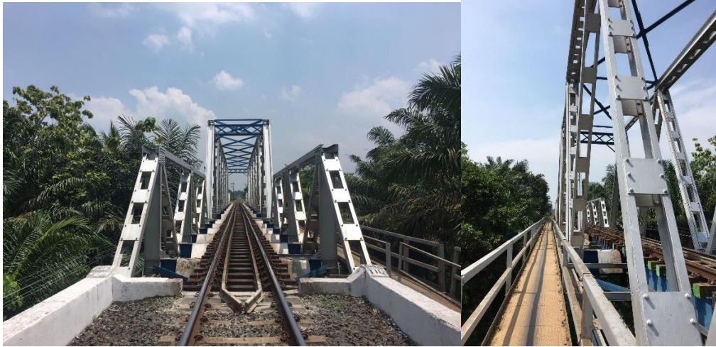
Gambar 6. Foto Visual Jembatan KA BH.116 Km 63+317
