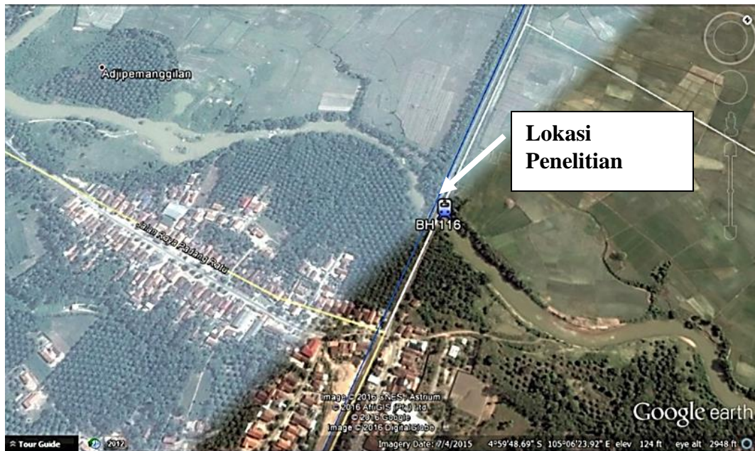
Gambar 5. Foto Satelit Jembatan KA BH.116 Km. 63+317.
