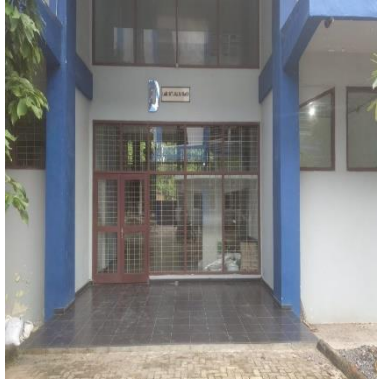
Gambar 3.2 Laboratorium Inti Jalan Raya
