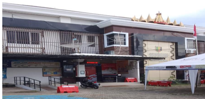
Gambar 3.1. Gedung UPTD Pendapatan Wilayah 1 Bandar Lampung (Sumber : Dokumentasi Pribadi)
