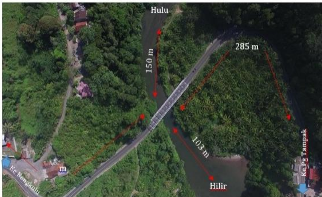
Gambar 2 Koridor Pengukuran Jembatan Way Halami
