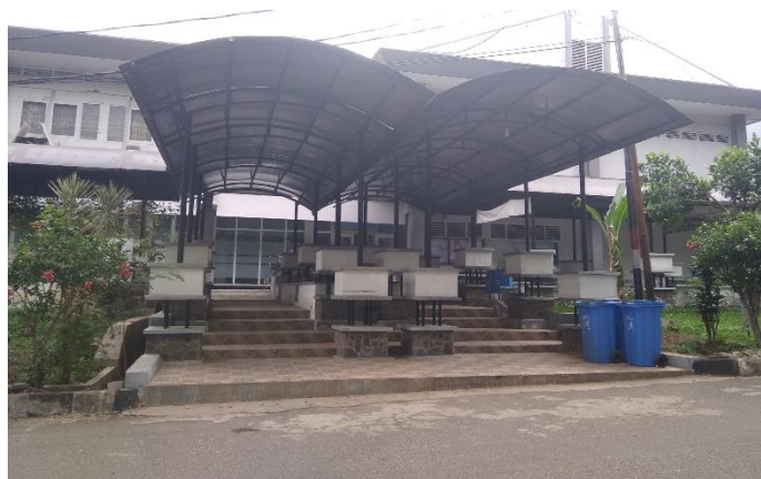
Gambar 15. Bagian belakang Gedung A Dekanat Fakultas Teknik.
