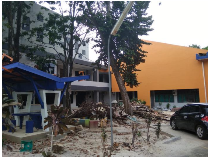
Gambar 19. Bagian belakang dari Gedung B Teknik Arsitektur.
