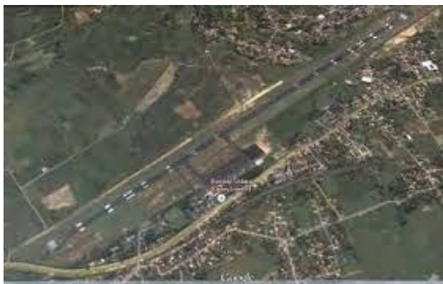
Gambar 2.3 Runway Bandar Udara Radin Inten II
