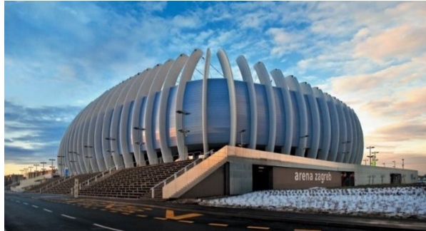
Gambar 2.7 Tampak Luar Bangunan Sumber : Archdaily
