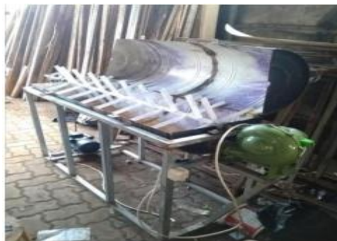
Gambar 16. Pemasangan motor listrik dan blower
