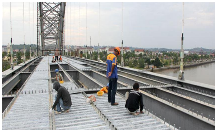
Gambar 4. Pelat lantai jembatan.
