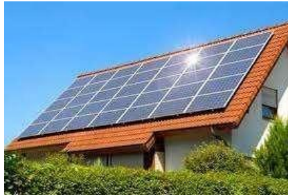
Gambar 2.9 Pemasangan Rooftop Rack
