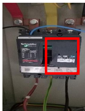
Gambar 3.18 menunjukkan posisi MCCB OFF
