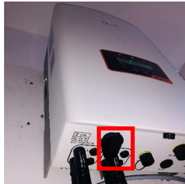
Gambar 3.10 cara menyalakan DC Switch pada Inverter
