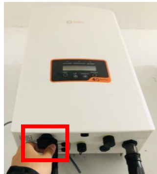
Gambar 3.16 cara mematikan DC Switch OFF
