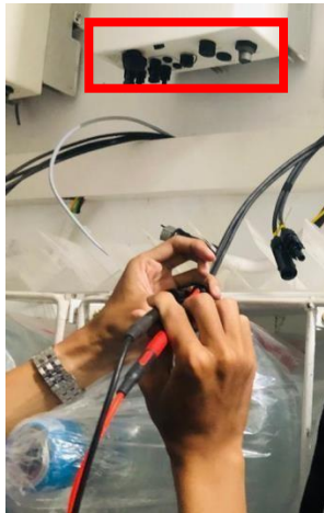
Gambar 3.17 cara melepas Kabel DC dan AC dari PV Inverter
