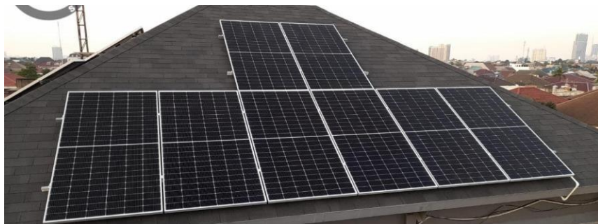
Gambar 3.1 area panel surya bersih dari kotoran dan bayangan
