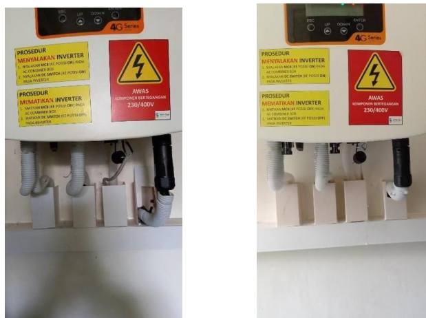
Gambar 3.4 koneksi kabel pada inverter
