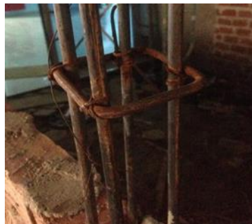
Gambar 3.17 : Besi Tulangan 8mm
