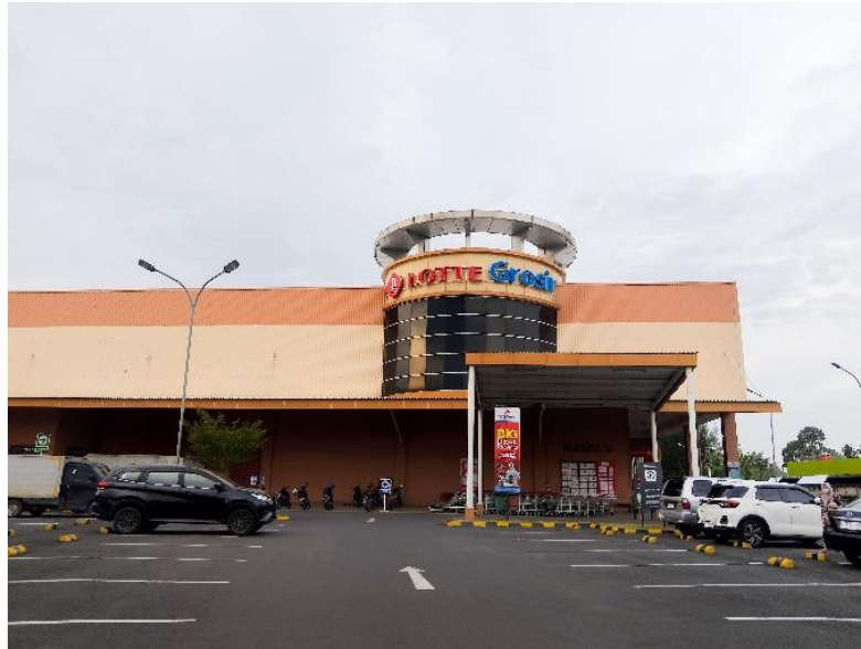
Gambar 1.1 Tampak Lotte Grosir Lampung
