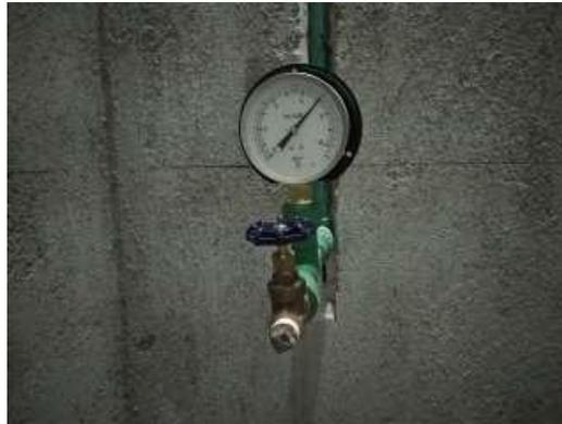
**Gambar 3. 18** Alat pengukur tekanan udara (*Pressure Gauge*)
