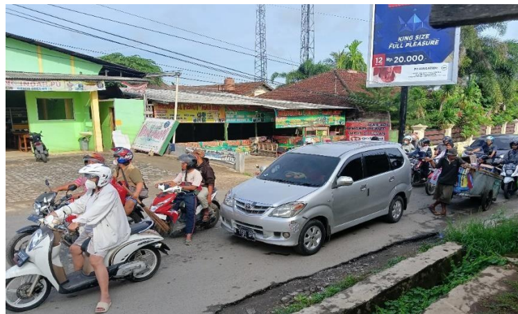
Gambar 13. Kondisi Ruas Jalan Soekardi Hamdani
