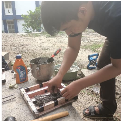
Gambar 28. Meletakkan jaring kawat dan tulangan.
