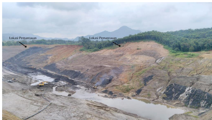
Gambar 2 Low Wall Lokasi Pemantauan (Sumber: Sekar, 2023)
