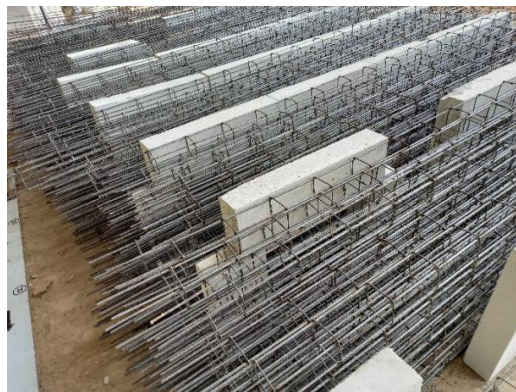
Gambar 3.15 Besi tulangan ulir 10 mm dan 6 mm
