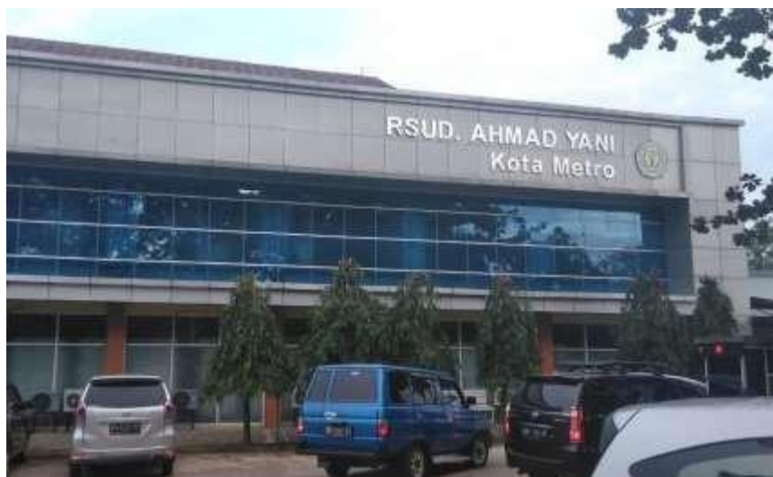
Gambar 3. 2 Gedung RSUD Jend. A. Yani Metro
