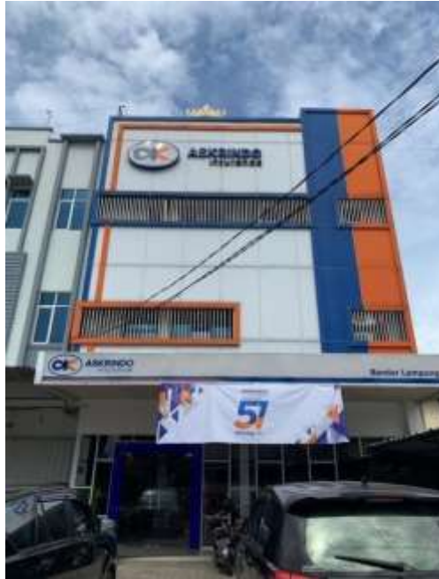
Gambar 3. 1 Gedung PT.Askrimdo cabang Lampung
