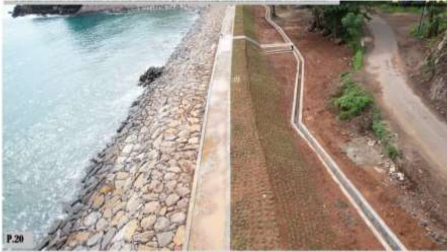
Gambar 3. Revetment Batu Pecah Sejajar Garis Pantai.
