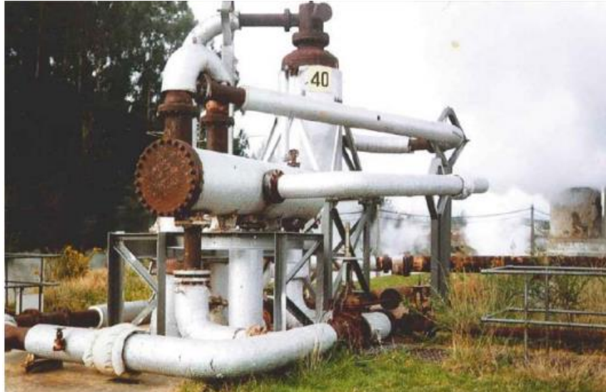
Gambar 1.1 U-Bend Separator
