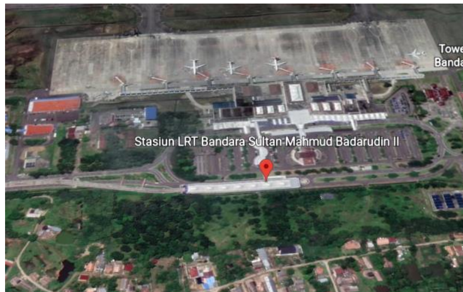
Gambar 3.1. Stasiun LRT Bandara.
