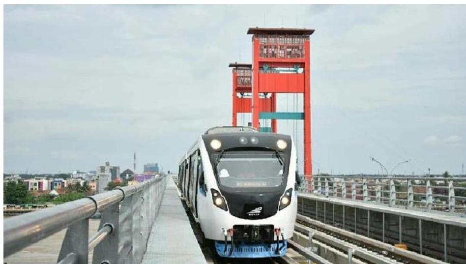
Gambar 3.4. Kereta LRT beroperasi di rel.
